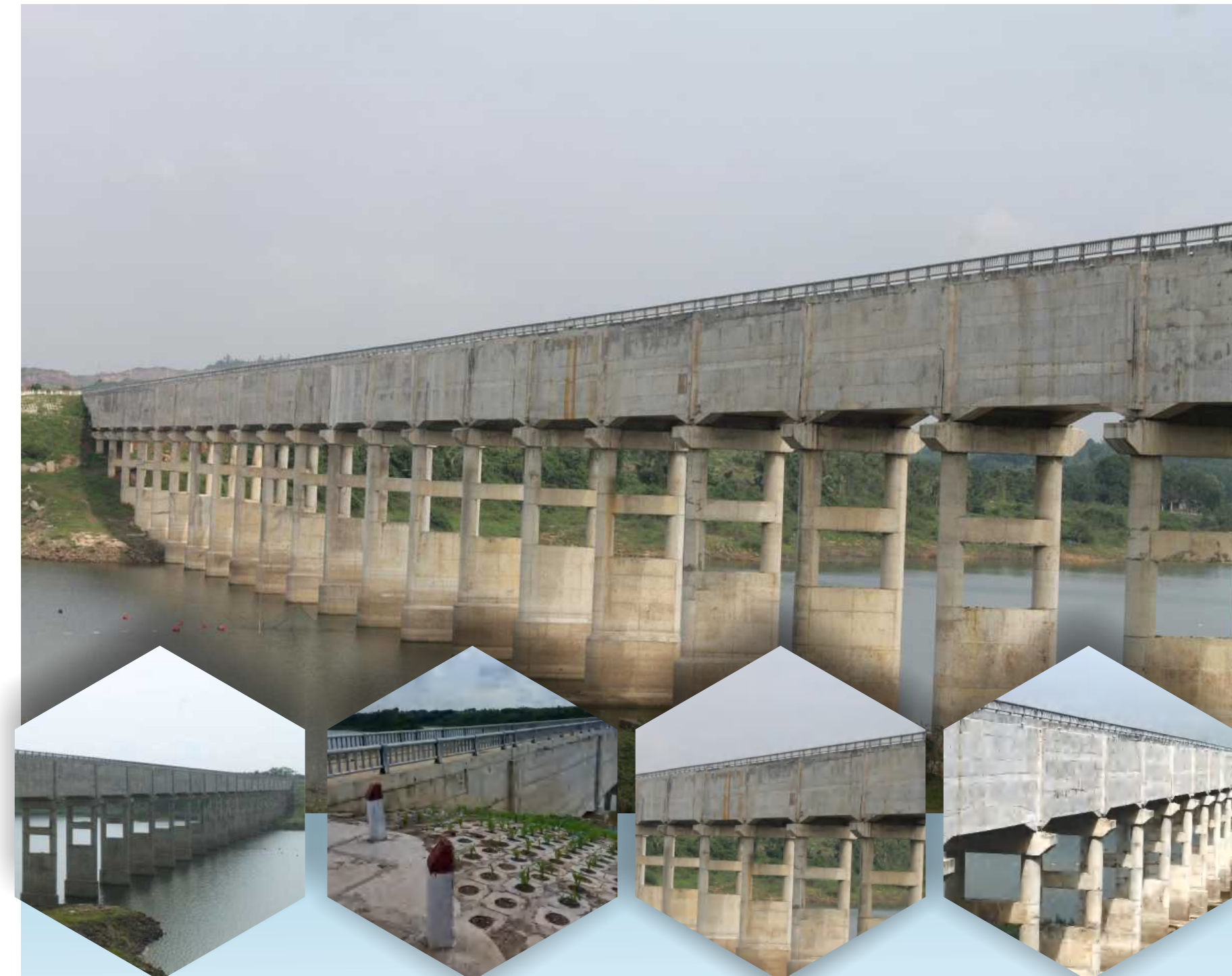
Cầu máng suối Giàu thuộc kênh chính đoạn 2 thuộc công trình Hồ chứa nước Sông Ray tỉnh BR-VT
