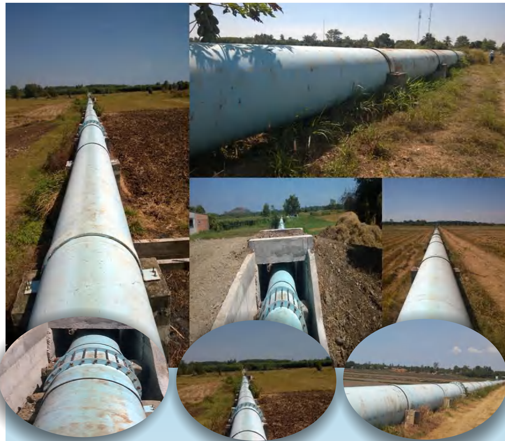
Xi phông vượt sông ray trên kênh chuyển nước sang Xuyên Mộc đoạn 3 ( Km7+500 – Km10+800) công trình Hồ chứa nước sông Ray Tỉnh BRVT
